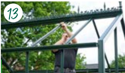
13 Danach werden die Dachsprossen am Giebel angebracht und verschraubt.
