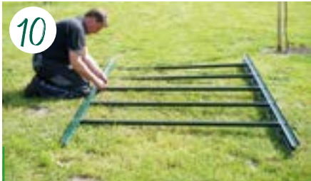
10 Die Seitenteile werden ebenso wie die Giebelwände flach liegend montiert.
