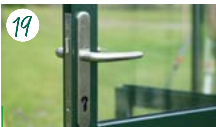
19 Jetzt wird das Schloss eingesetzt und verschraubt. Türfeststeller und Magnetfeststeller folgen.
