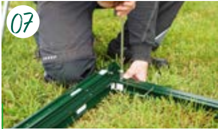
07 Nach dem Entpacken werden die Randsprossen ausgelegt und verschraubt.
