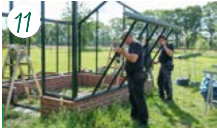
11 Guter Fortschritt: Das baukastenähnliche System funktioniert und schon bald ist nur noch ein Seitenteil zu montieren.
