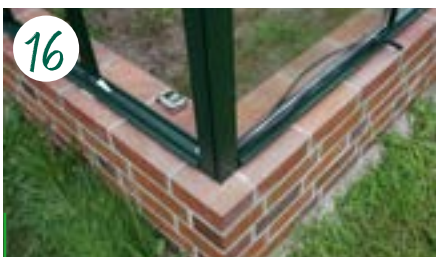
16 Nach der Verglasung werden die Gummidichtungen eingesetzt.
