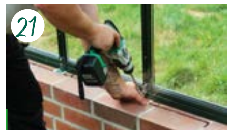
21 Das Gewächshaus wird mit den vorgesehenen Halterungen in das Fundament gebohrt und so verankert.
