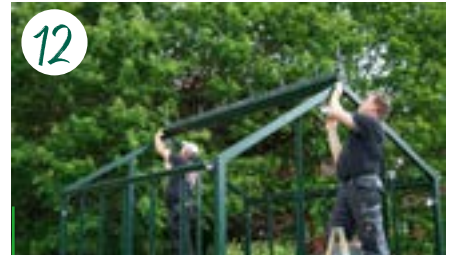
12 Jetzt kann der Giebel mit der restlichen Konstruktion verschraubt werden.
