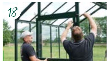
18 Montage der Tür: Diese kommt in zwei Teilen und ist größtenteils vormontiert.
