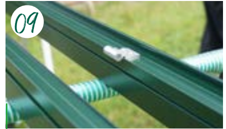
09 An der zweiten Giebelwand wird das Tür-Element für den späteren Gewächshaus-Eingang verschraubt.
