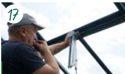
17 Anschließend wird das Dachfenster samt automatisiertem Fensteröffner eingesetzt.
