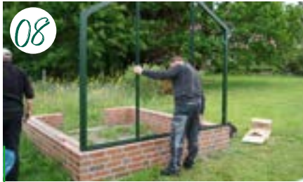
08 Der erste Giebel steht auf dem Fundament.
