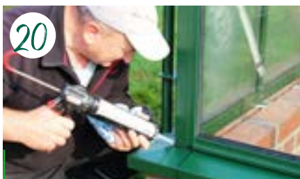
20 Eine Verkleidung des oberen Gewächshaus-Sockels verhindert stehendes Wasser auf dem Mauerwerk.
