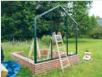
Nützlicher Trick - Eine Leiter dient als temporäre Stütze für die Giebelwand
