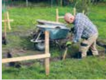
An den Schnüren entlang wird mit einem Spaten ein 25 cm breiter Graben ausgestochen. (Grabtiefe ca. 60 - 70 cm)
