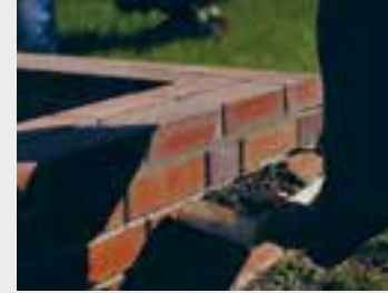
Nach Mauern des Sockels werden die Lager- und Stoßfugen ausgefugt
