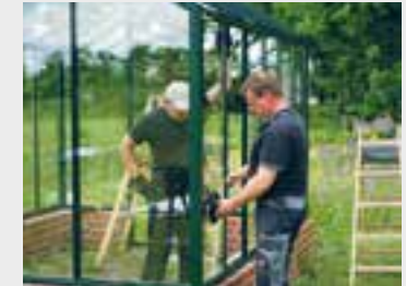
Jetzt zur Verglasung. Die Ecken werden dabei immer zuerst verglast – auch im Giebel
