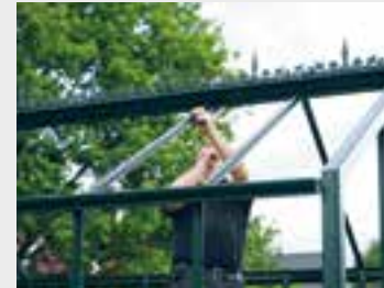
Nach dem Giebel werden die Dachsprossen an dem First angebracht und mit der restlichen Konstruktion verschraubt
