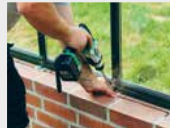
Zur abschließenden Befestigung des Gewächshauses wird mit vorgesehenen Halterungen in das Fundament gebohrt und so das Gewächshaus mit Schrauben verankert
