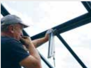
Anschließend wird das Dachfenster samt automatischem Fensteröffner eingesetzt
