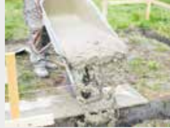
Der Fundamentgraben wird bis zur Oberkante mit Beton gefüllt
