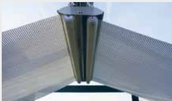
Befestigung mit Ketten am First
