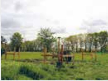
Gewächshausfläche ausmessen und die Ecken mit jeweils 3 Holzpfählen abstecken
