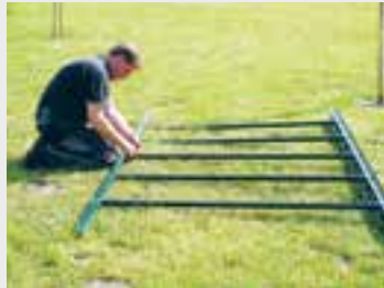
Die Seitenteile werden ebenso wie die Giebelwände flach liegend montiert
