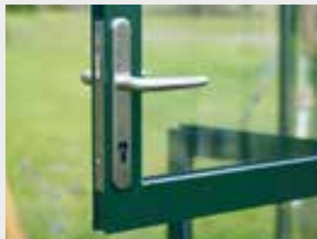
Ist die Tür drin, wird das Schloss eingesetzt und verschraubt. Türfeststeller und Magnetfeststeller folgen
