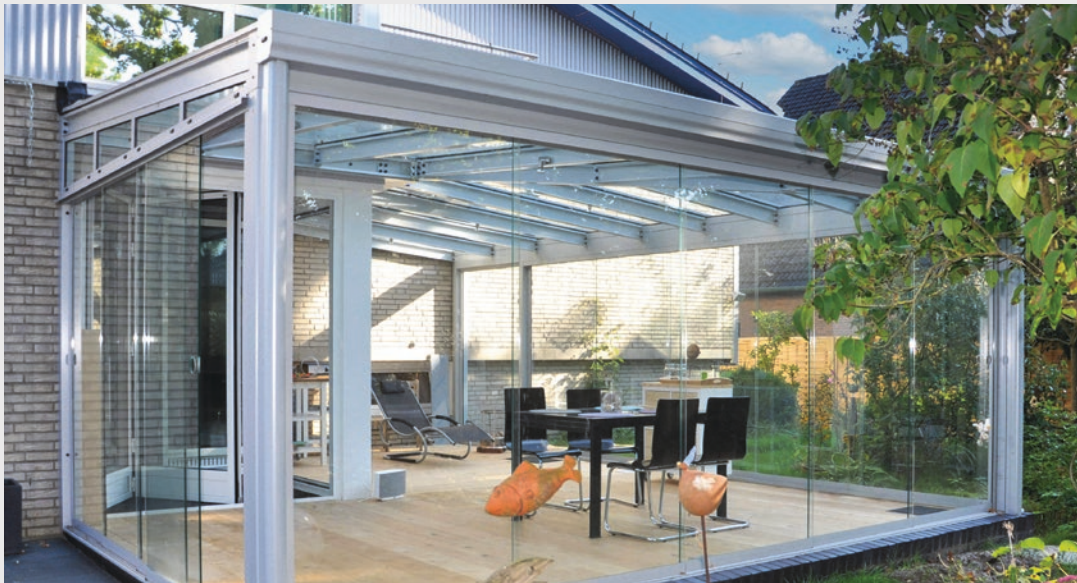
Terrassenüberdachung aus komplett feuerverzinktem Stahl mit Ganz-Glasanlage
