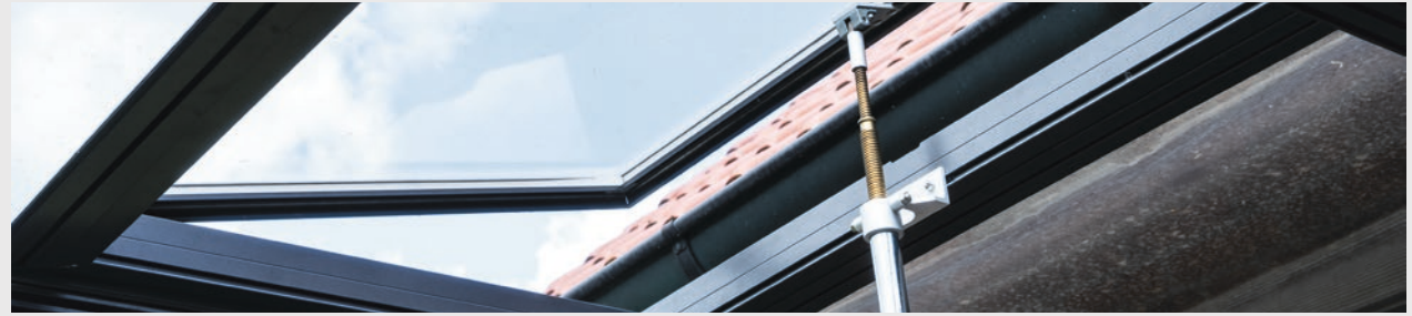
Dachfenster mit Spindelantrieb und Handkurbel
