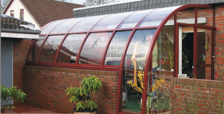
Aufgemauerte Solarveranda Berlin
