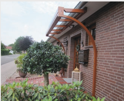
Pulverbeschichtetes Aluminium-Vordach als Pultausführung
