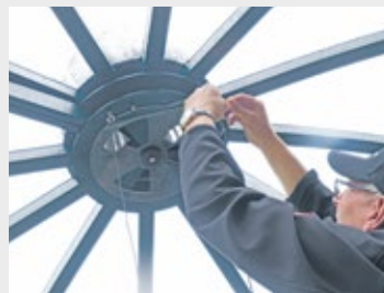
Bedienbänder an der Verschlussklappe befestigen stufenlosen Regulierung des Windradlüfters
