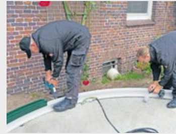
Mit den Edelstahlschrauben die Laufschiennen aufdübeln
