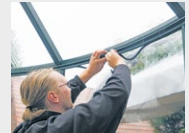
Glasdichtungen von innen zwischen der Dachglasscheibe und dem Traufprofil einsetzen
