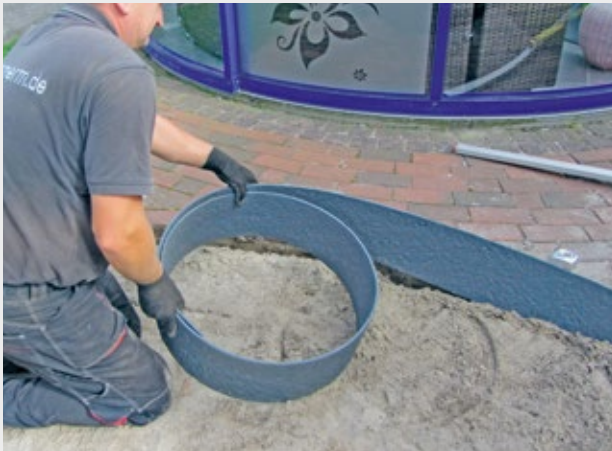
Ecoflex: Ideale Einfassung aus 100 % recyceltem Kunststoff, auch für Beet- und Raseneinfassungen
