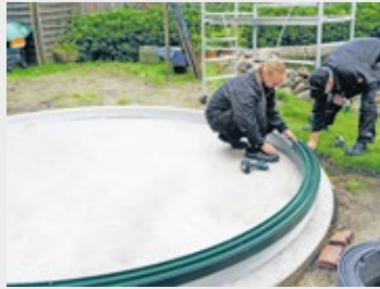
Fundamentrahmen an der vorbereiteten Betonplatte befestigen
