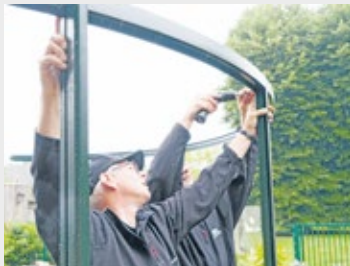
Seitensprossen mit dem Traufprofil verschrauben
