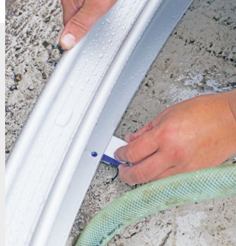
Tipp: Laufschienen mit kleinen Glasklötzen ausgleichen für das spätere Fixieren
