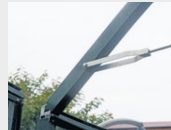
Spannungsstange an den Dachsparren befestigen, um zu verhindern, dass das Traufprofil nach außen gedrückt wird
