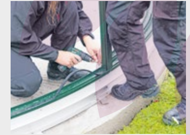
Seitensprossen mit Edelstahlschrauben (vorher in Mehrzweckfett getaucht) am Laufrollenprofil befestigen
