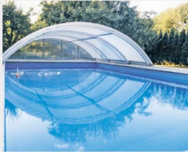
Schwimmbadüberdachung Sylt A
