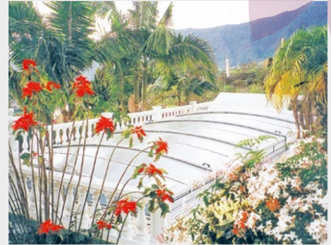
Sylt B – verschiebbare Überdachung mit Seitenelementen
