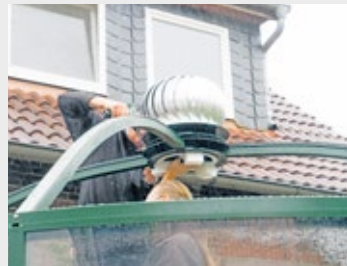
Windradlüftung auf die befestigten Dachsparren aufsetzen und miteinander verbinden
