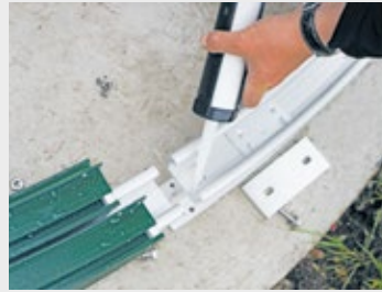
Laufschiennenverbindungen mit Silikon abdichten
